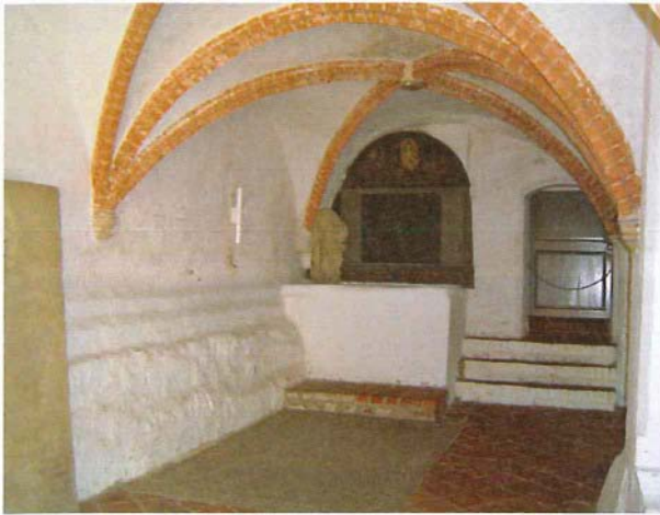
Abb. 2: Blick auf die südöstliche Mauer der Klosterkirche mit freigelegtem Fundamentbereich.
