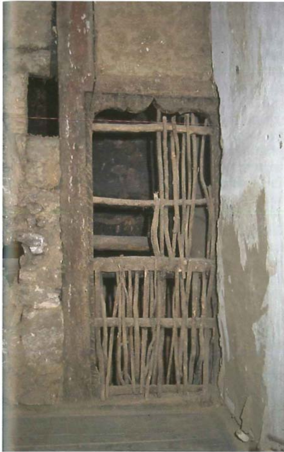
Abb. 3: Göttingen, Johannisstr. 26: Bei der Freilegung einer Wand wurde im Hausinneren eine verdeckte Tür mit einem Vorhangbogen freigelegt (Foto: Stadt Göttingen, Stadtarchäologie)
