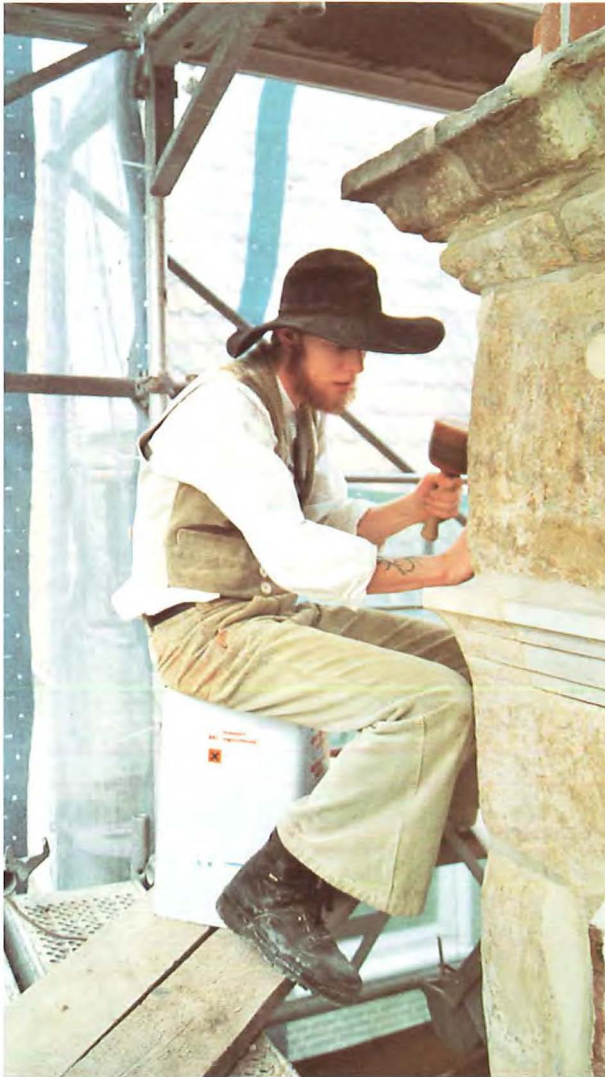
Abb. 4 Ein Steinmetz auf Wanderschaft bei Restaurierungsarbeiten
