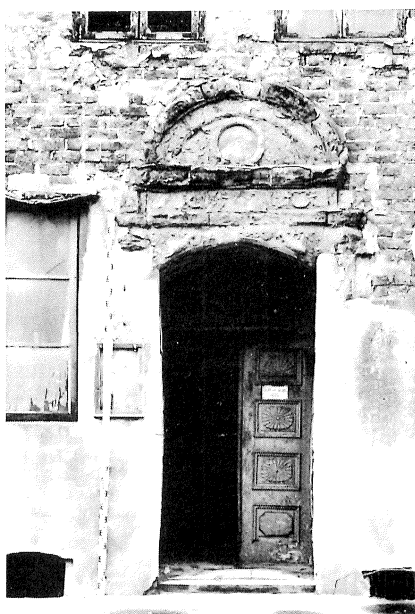
Abb. 2. Lüneburg, Neue Sülze 8, Terrakotaportal, Aufnahme kurz vor dem Abriß 1961, Photo: Museum für das Fürstentum Lüneburg
