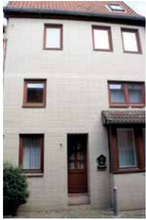
Abb. 8: Koltmannstraße 4 (HSR Architekten 2015)
