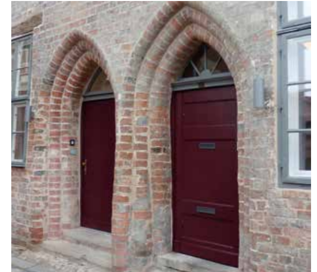
Abb. 7: Papenstraße 6: rekonstruierte Eingangssituation (D. Braun 2017)
