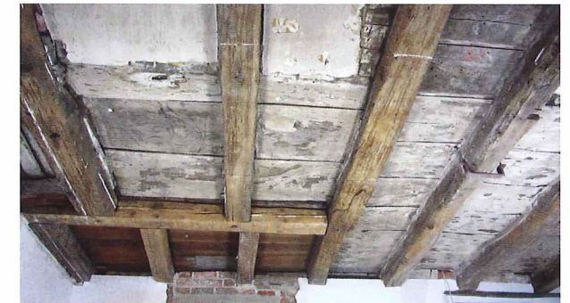
Abb. 1: Die 2018 freigelegte Decke von 1304 im ersten Obergeschoss des Alten Münzhauses (Nord-Ost-Ecke).
