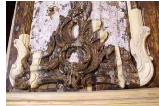
Abb. 3: Schröderstraße 7: bildhauerische Ergänzung fehlender Zierelemente (Blohm und Tillwick 2014)
