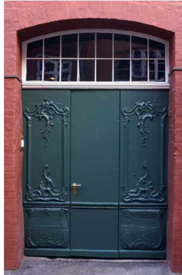
Abb. 2: Schröderstraße 7: Rokokoportal nach der Restaurierung (Blohm und Tillwick 2014)
