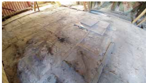
Abb. 8: Obergeschoss, freigelegter Fußboden.
