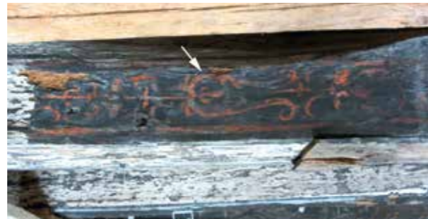
Abb. 13: Unterhalb der Barockfassung wird eine Renaissancemalerei des 16. Jahrhunderts sichtbar – orangerote Arabeskenranken auf schwarzem Grund, ein für Lüneburg einmaliger Befund.
