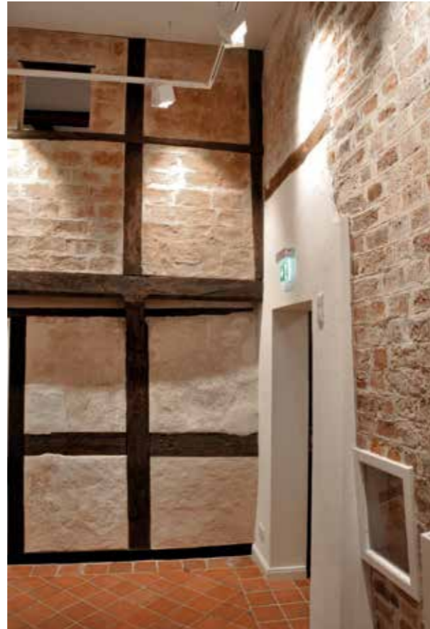
Abb. 13: Erdgeschoss, restaurierte Dielen-Fachwerkwand.
