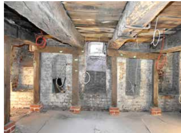
Abb. 14: Wand Westen Keller 1
