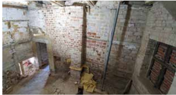
Abb. 6: Erdgeschoss Luftraum Blick auf südliche Trennwand, links Dielen-Fachwerkwand.
