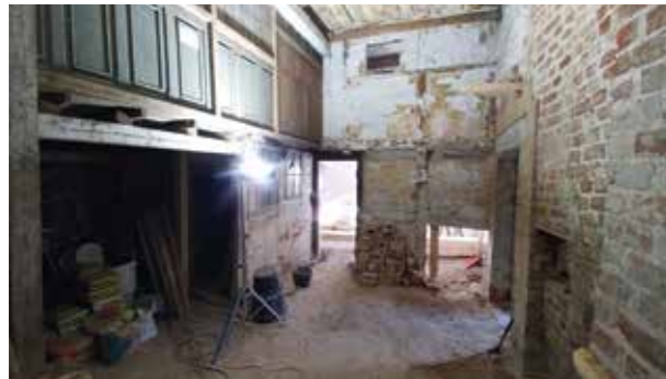
Abb. 7: Erdgeschoss Luftraum, Blick auf Dielen-Fachwerk mit historischer Holzbelegung.
