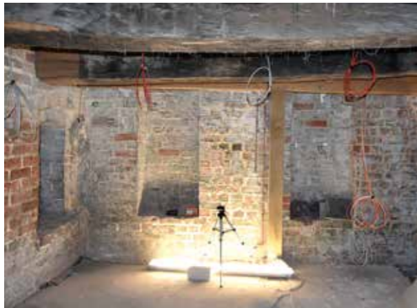
Abb. 13: Wand Süden Keller 1
