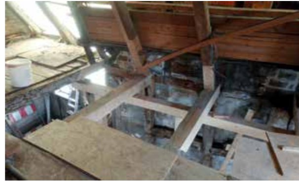
Abb. 10: Dachgeschoss nach Süd, Reparaturverbindungen an Holzkonstruktion.
