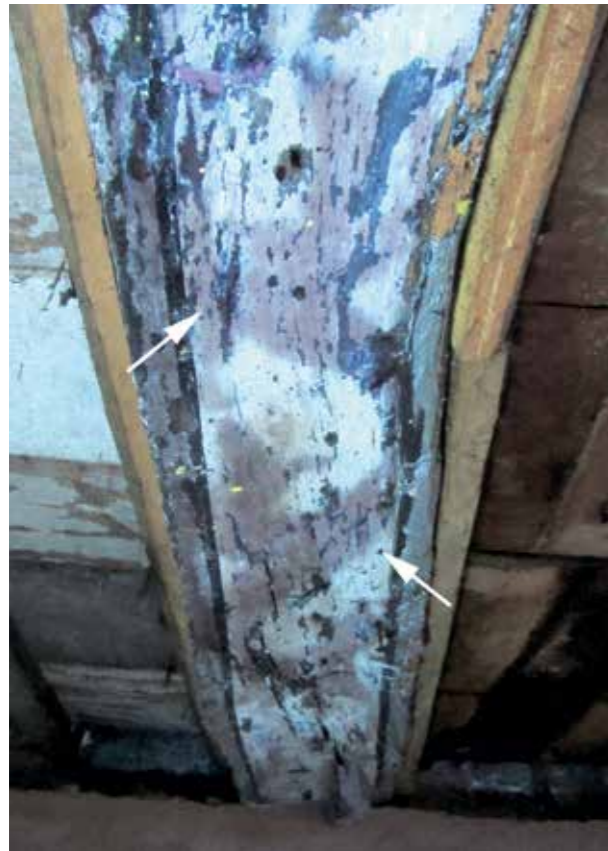
Abb. 12: Die Spuren einer gotischen Ranke am Balken unter UV-Strahlung.
