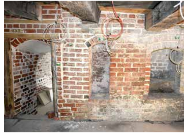
Abb. 12: Wand Osten Keller 1 rechte Hälfte
