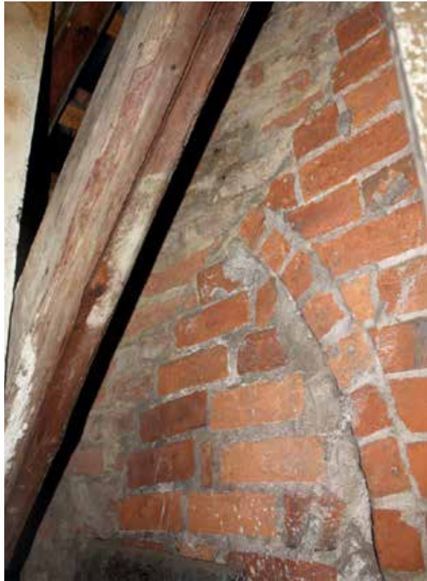
Abb. 2: Vermauerte Fensteröffnung mit Ansätzen eines Spitzbogenportals in der früheren östlichen Außenwand.
