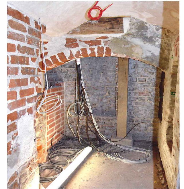
Abb. 1: Innenbereich der Abtrennung Keller 1
