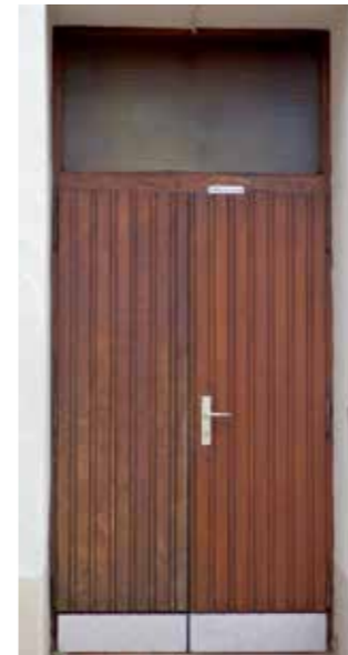
Abb. 24: Auf der Altstadt 13, 14: Bestandstür (D. Braun 2017)
