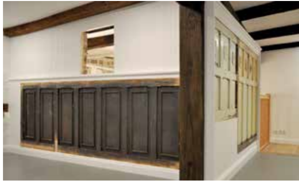
Abb. 11: Zwischengeschoss: Wiederverwendete historische Holzbekleidung.
