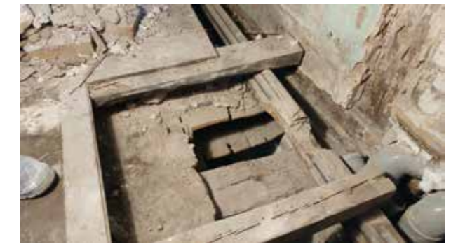
Abb. 9: Obergeschoss, Unterkonstruktion aus Holzhandlauf
