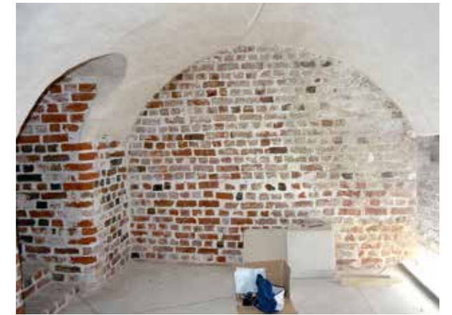
Abb. 20: Wand Norden Keller 2
