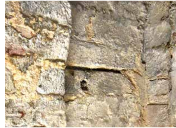
Abb. 15: Nische Wand Westen Keller 1
