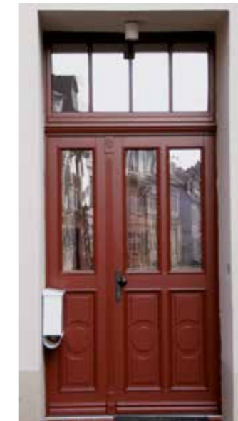
Abb. 25: Auf der Altstadt 13, 14: erneuerte Tür (D. Braun 2018)
