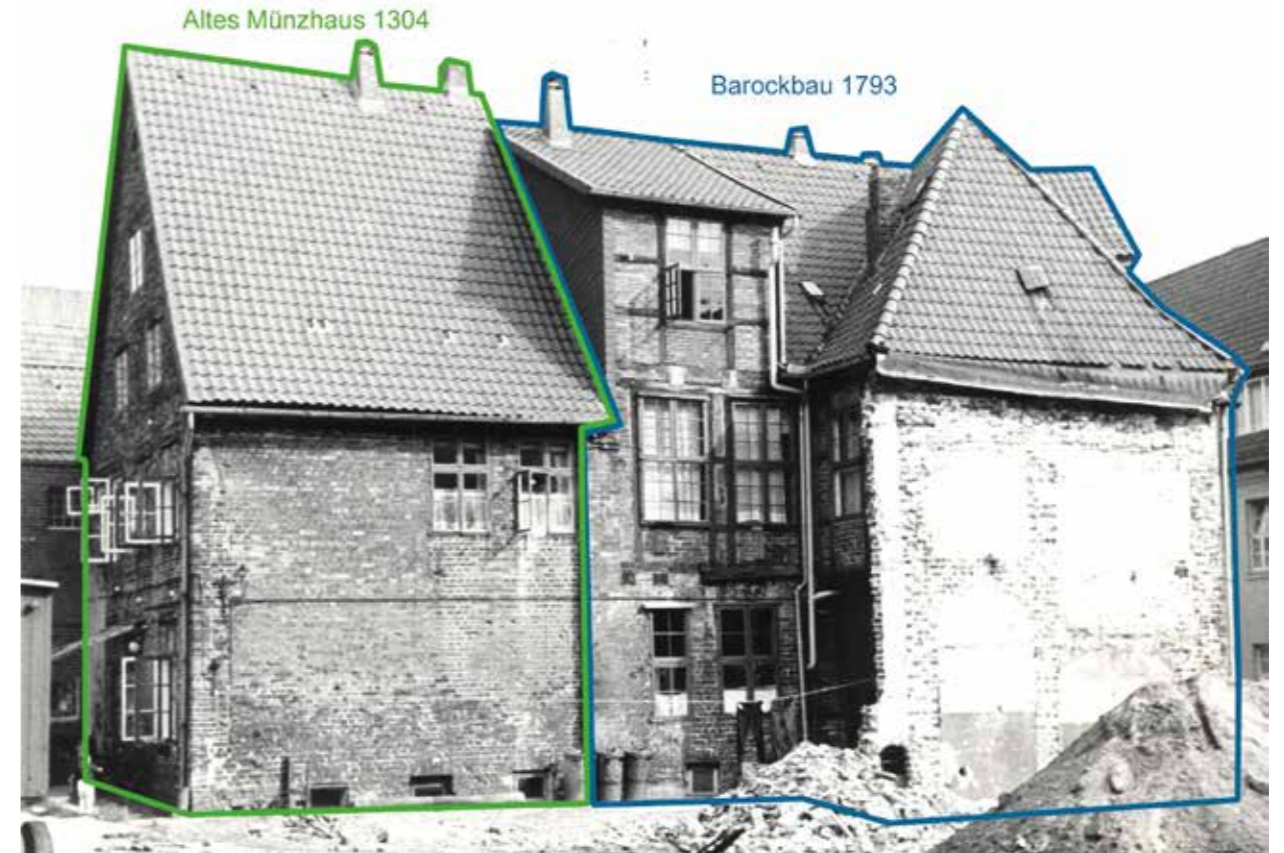
Abb. 5: Ansicht des Komplexes aus Südwesten während des Abrisses der Häuser An der Münze 4-6 im Herbst 1967. Foto: H. Werner.
