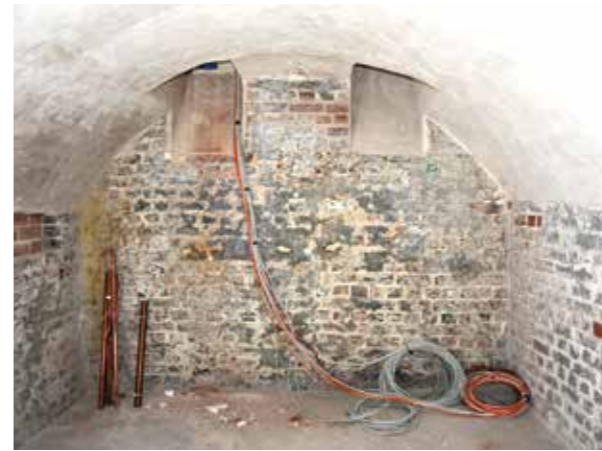
Abb. 19: Wand Süden Keller 2
