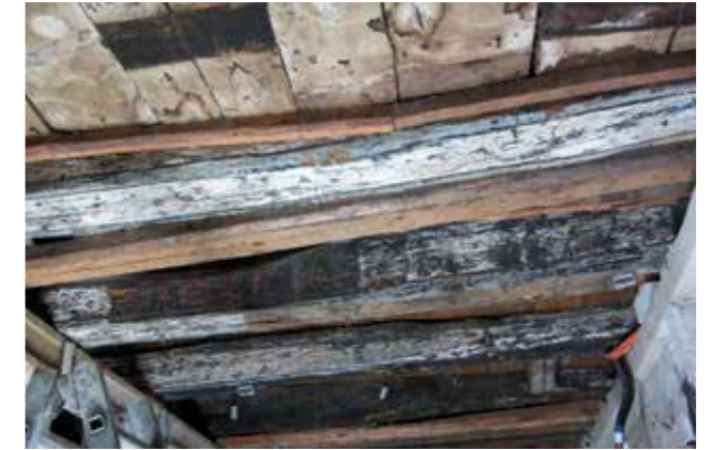
Abb. 11: Die bauzeitlichen Deckenbalken im Erdgeschoss des Alten Münzhauses tragen Reste einer gotischen Rankenmalerei, eine Renaissancefassung und eine Gestaltung der Barockzeit.
