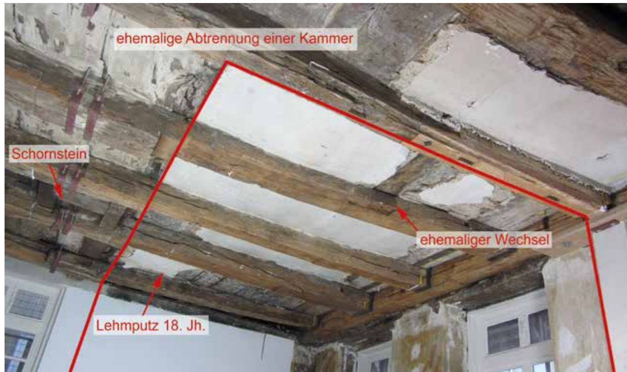
Abb. 2: An der Westseite erkennt man Spuren ehemaliger Raumtrennungen des 17. + 18. Jahrhunderts.
