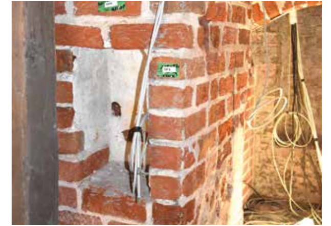
Abb. 16: Pfeiler mit Lichtnische
